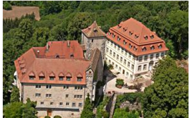
Nach zwei jähriger Renovierung erstrahlt das Barockschloss (rechts) nun in neuem Glanz.
